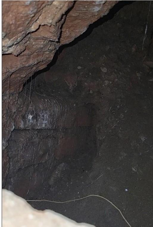
**Figura 9. Tunnel parzialmente occluso da frana. L'immagine è stata scattata attraverso una piccola feritoia della tamponatura della galleria principale.**
