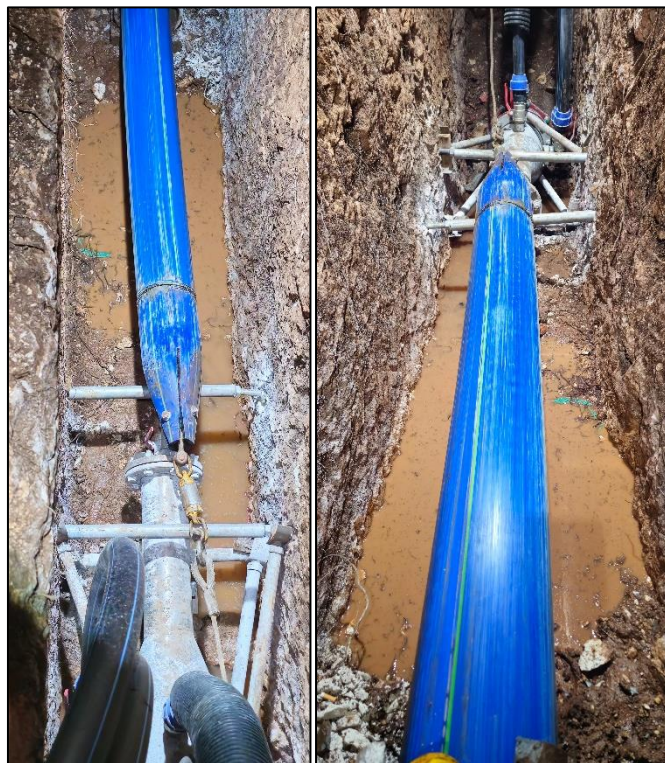
Figura 10 Controllo visivo calibro
