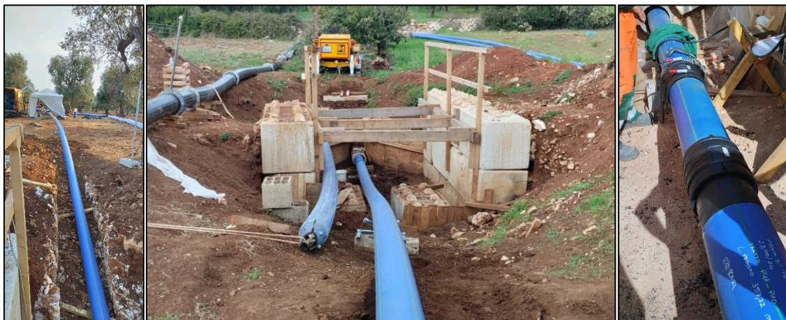
Figura 11B Inserimento tubo PE
