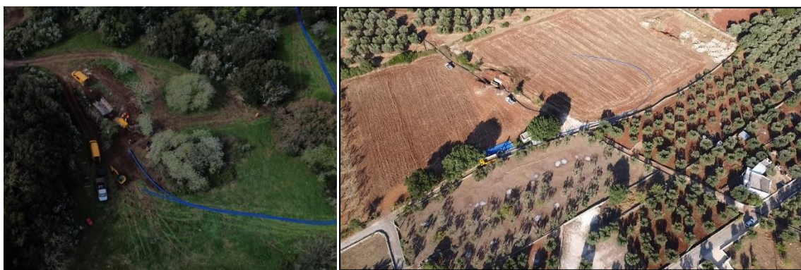
Figura 11A Vista dall'alto di un inserimento tubo in PE
