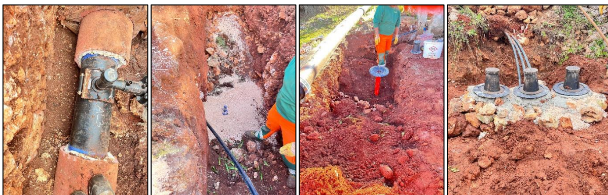
Figura 12 Collegamento derivazione utenze
