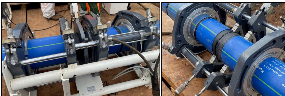
Figura 5 Fase saldatura
